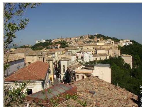
vue depuis la terrasse sur toit
