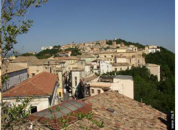
vue depuis la terrasse sur toit
