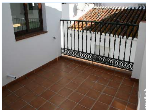
vue depuis la terrasse sur toit
