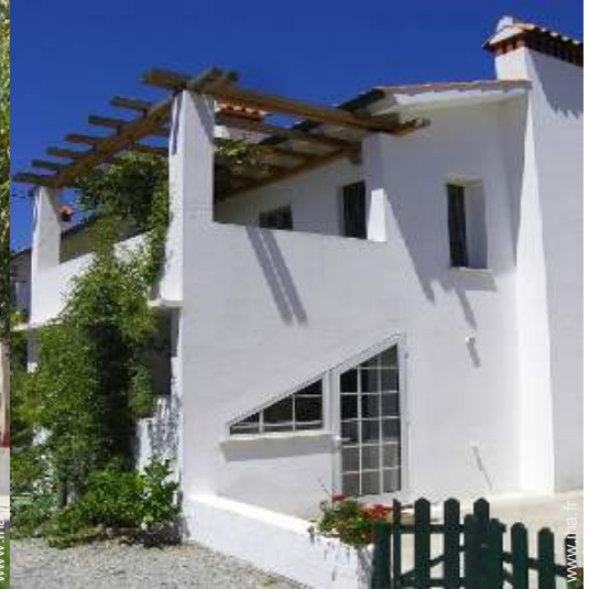
terrasse sur toit
