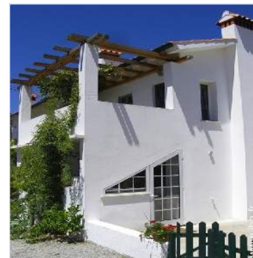
terrasse sur toit
