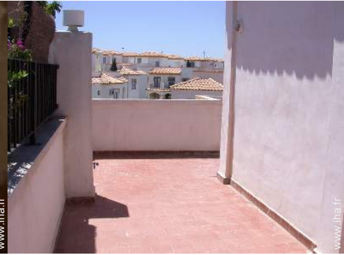
terrasse sur toit
