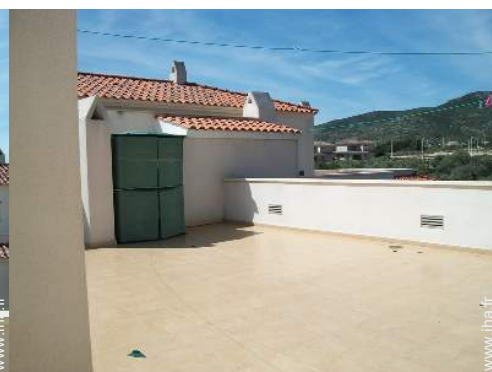
vue depuis la terrasse sur toit
