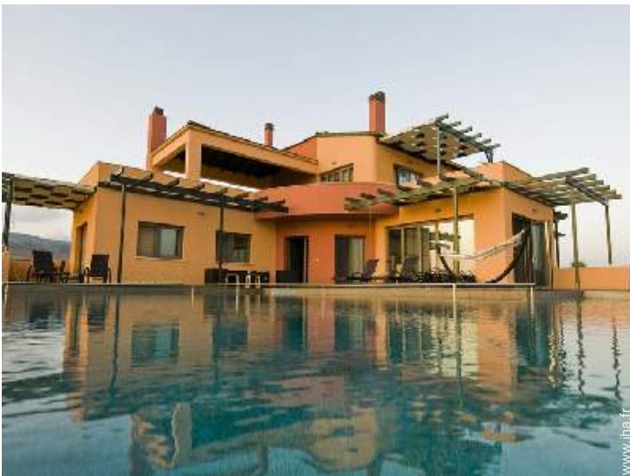
Piscine d'eau de mer
