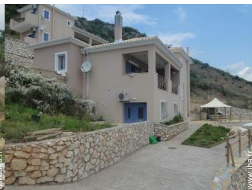
vue depuis la maison
