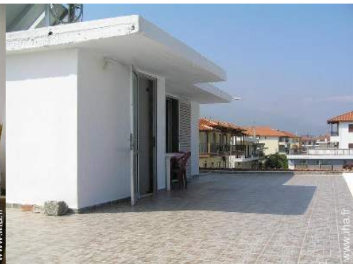
vue depuis la terrasse sur toit
