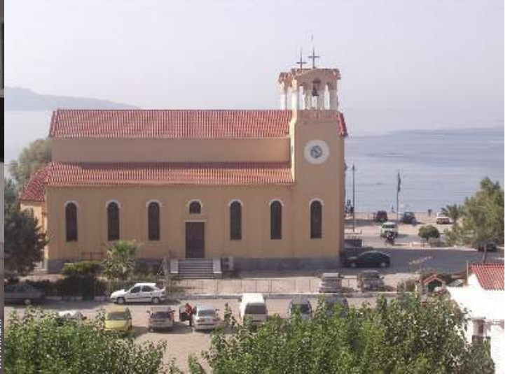
vue depuis la terrasse sur toit
