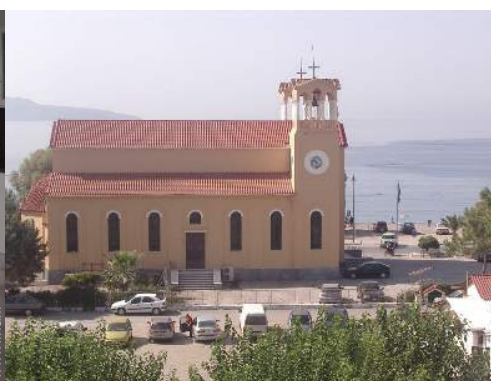
vue depuis la terrasse sur toit
