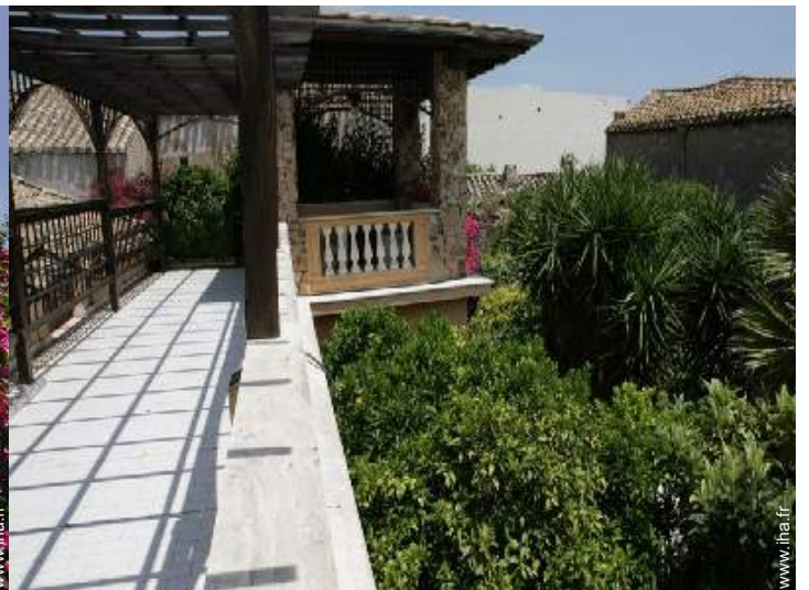
terrasse sur toit
