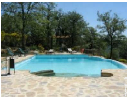
Piscine à débordement
